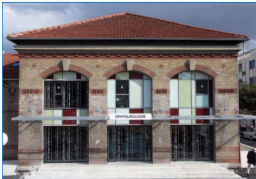
FIG. 1 : Centre Cochin Ambulatoire d'Ophtalmologie. En 1998 s'ouvrait la première unité d'ophtalmologie exclusivement ambulatoire dans un CHU français, désormais transférée dans un bâtiment rénové conçu pour ce mode de prise en charge.
